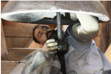
Der neu geschmiedete Klöppel wird an der Bronzeöse befestigt
