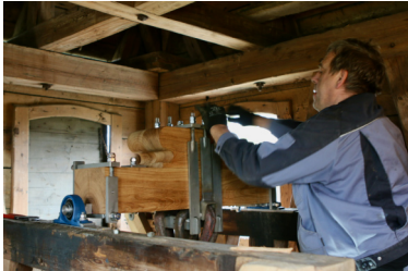
Die Glocke wird in der Glockenstube an das neue Joch montiert.
